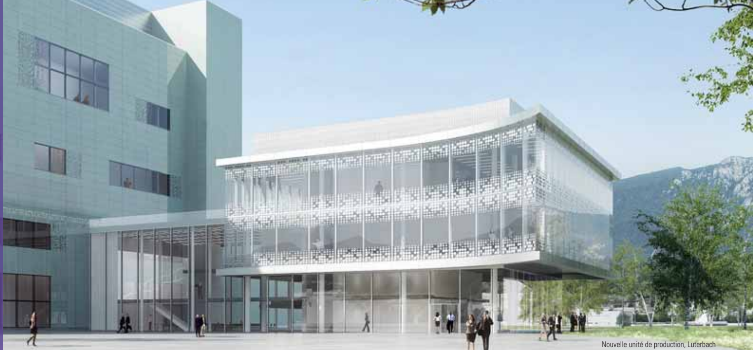
Nouvelle unité de production, Luterbach
