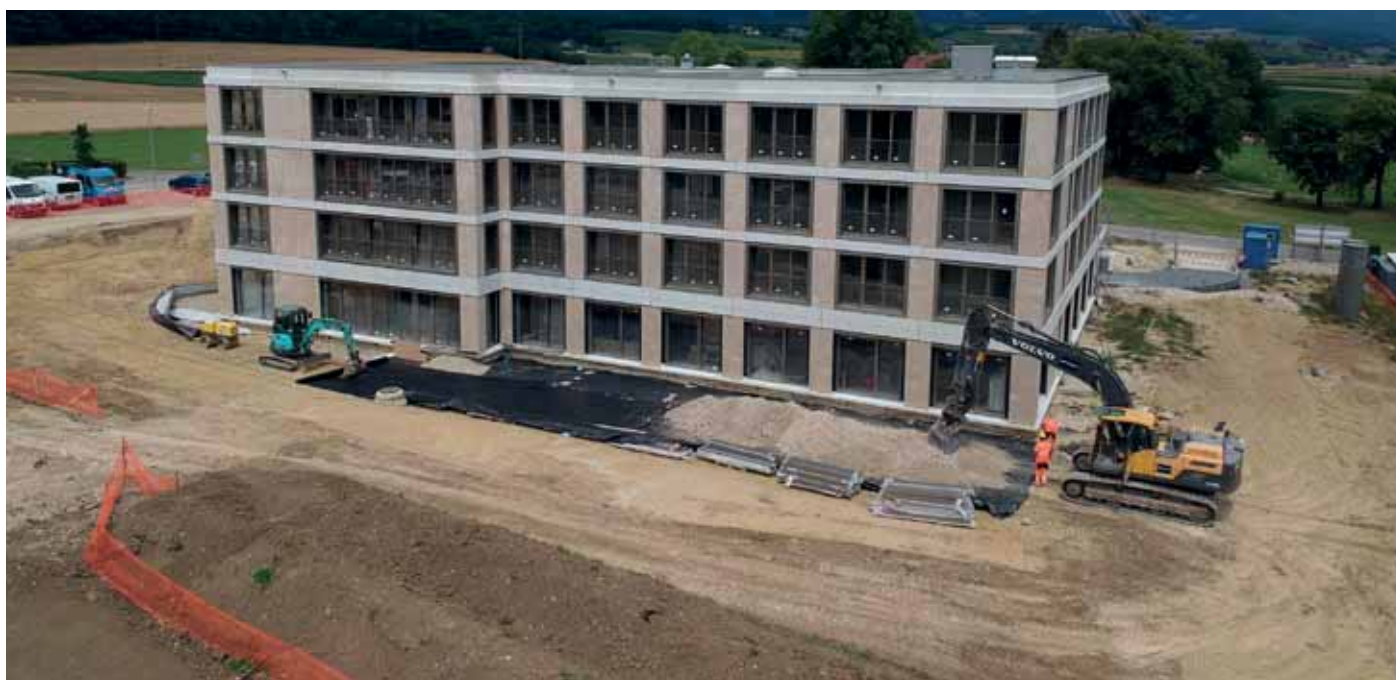
Chantier de l'EMS Montchoisi
