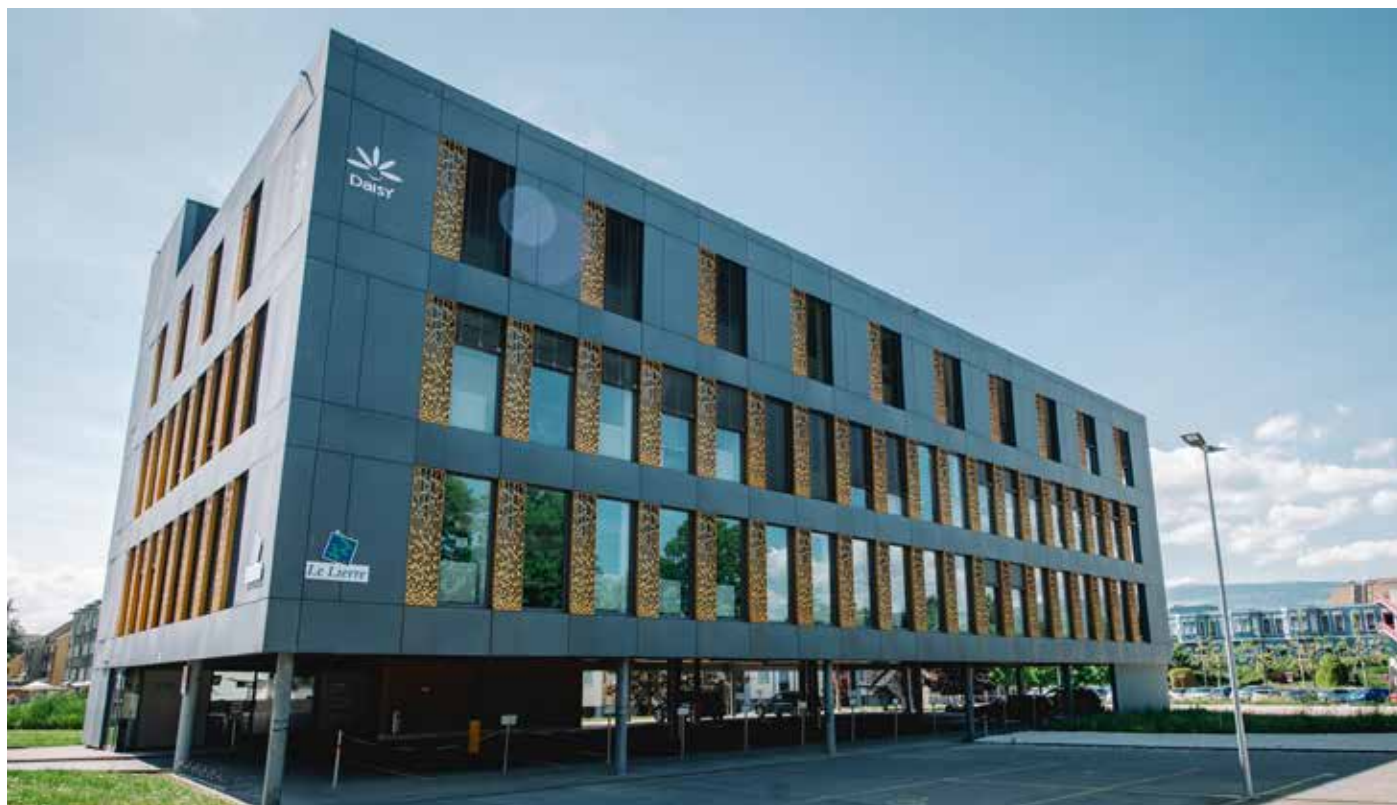
eHnv - Site d'Yverdon - Bâtiment Le Lierre
